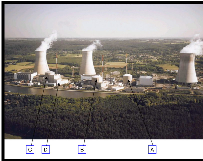
Figure 3 : Installations sur le site de Tihange
