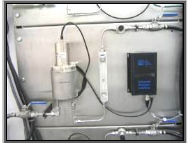
Figure 17 : Dispositifs de contrôle permanent des rejets d'effluents gazeux dans l'établissement Bêta Plus Pharma à Bruxelles
